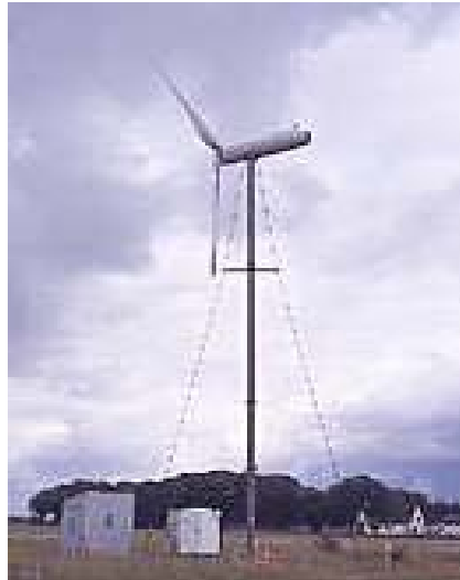
Figura 13 - Aerogerador com rotor a sotavento (downwind) [10].
