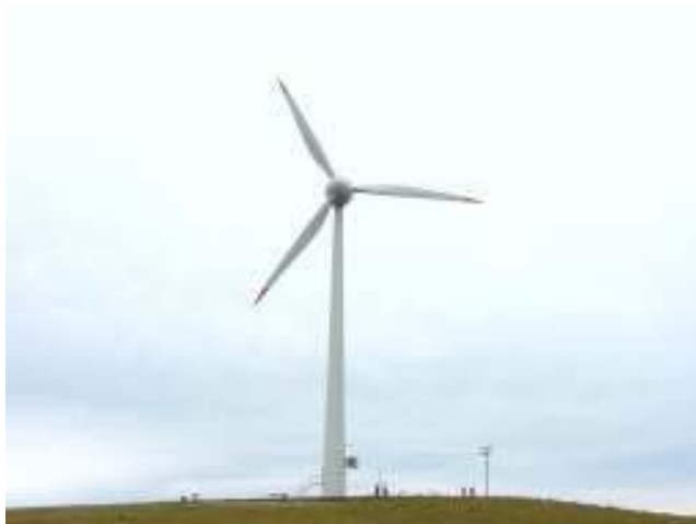
Figura 12 – Aerogerador da usina eólica de Bom Jardim da Serra (Santa Catarina) [10].
