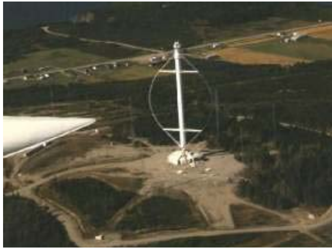
Figura 9 – Aerogerador tipo Darrieus [10].
